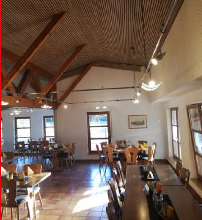
Die Gasträume mit den neuen Decken.
