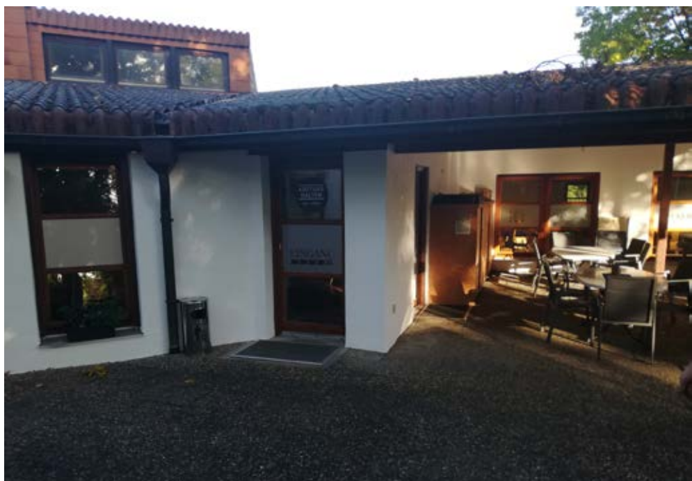
Nach den Fassadenarbeiten erstrahlt das Vereinsheim in neuem Glanz.
