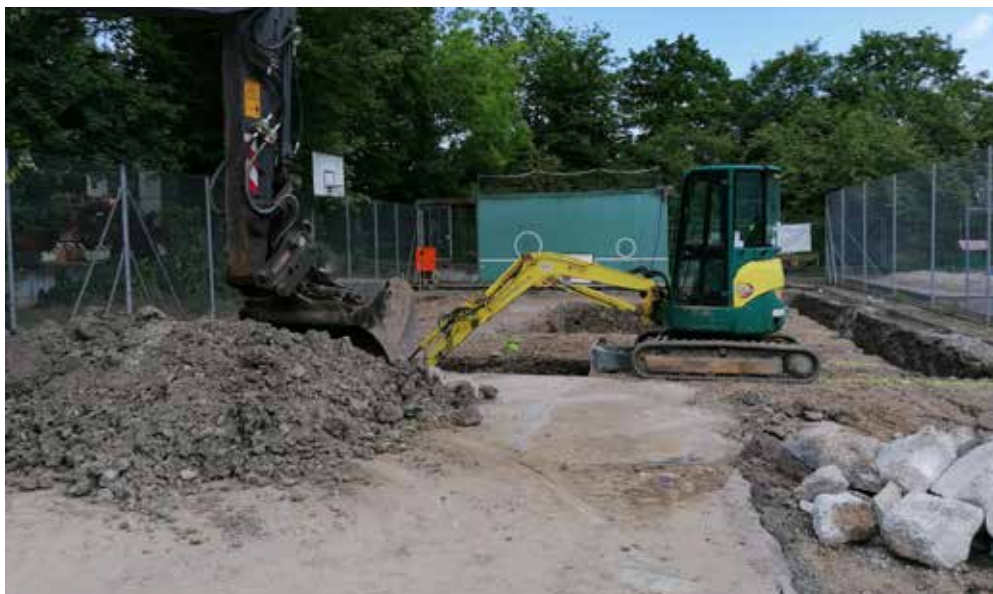
Die Bagger rücken an.
