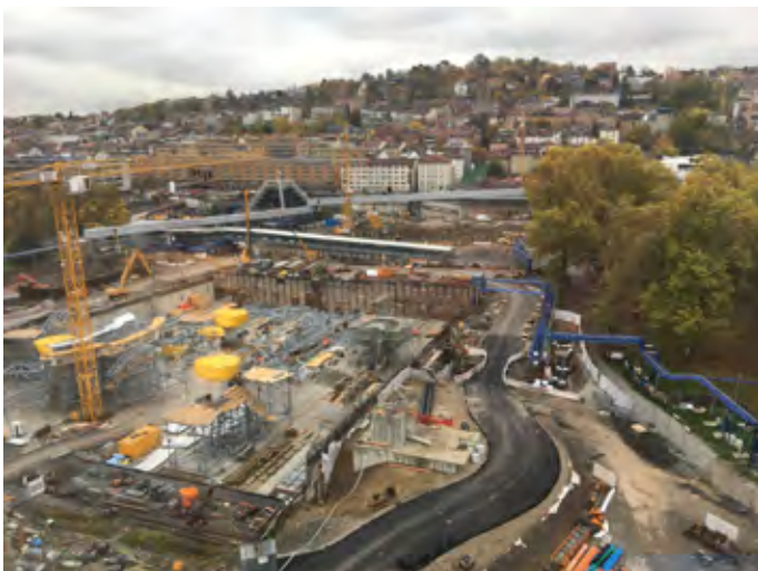
Blick auf die Baustelle.
