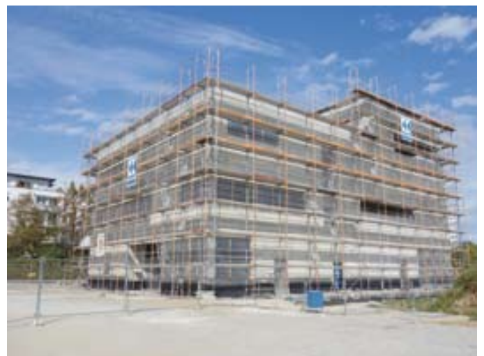
Der Rohbau ist nach 113 Tagen fertig.
