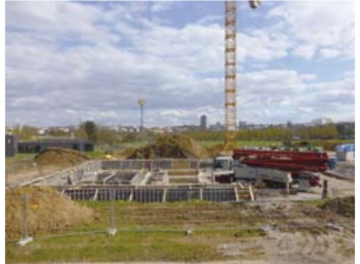
Bereits zwei Wochen später – das Fundament wird gebaut.
