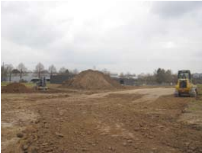
Mitte März 2016 haben die Bauarbeiten begonnen.
