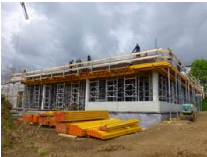
Gerätegestützter Trainingsbereich, Eingangsbereich, Bistro und Empfangstheke entstehen im Erdgeschoss.
